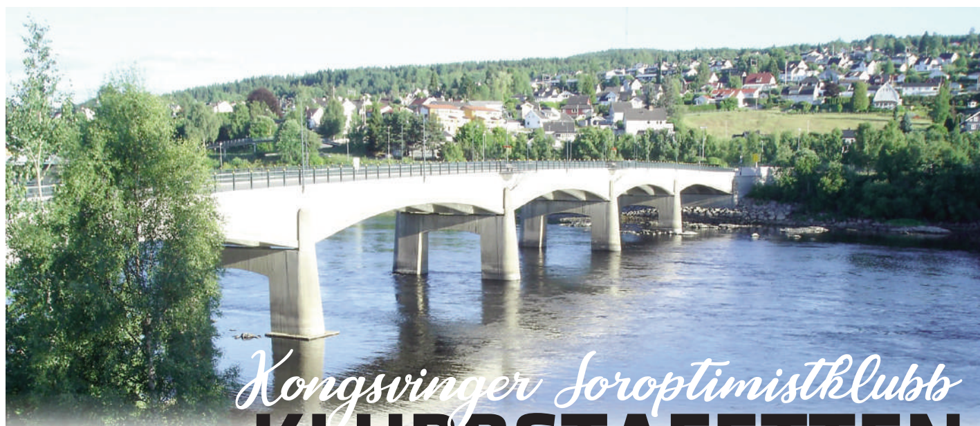
Gjemselund bru. FOTO: Karin Guttormsen
