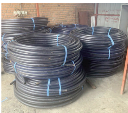
Vannledningene som skal graves ned, ligger klare til bruk!
